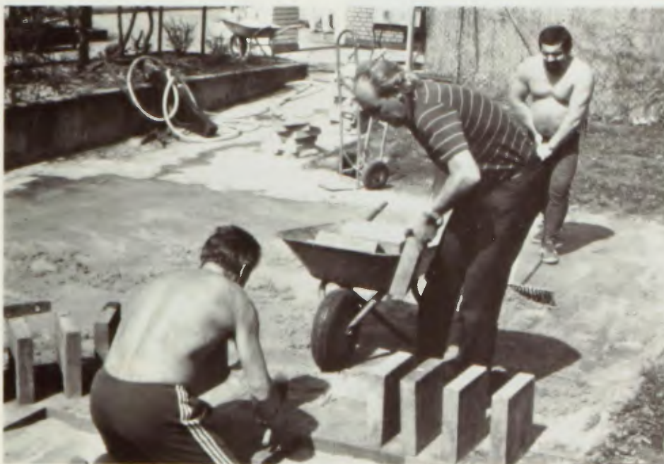
H. Böttger, G. Müller und S. Weinfurtner beim Bau einer Terrasse im Clubbad.
