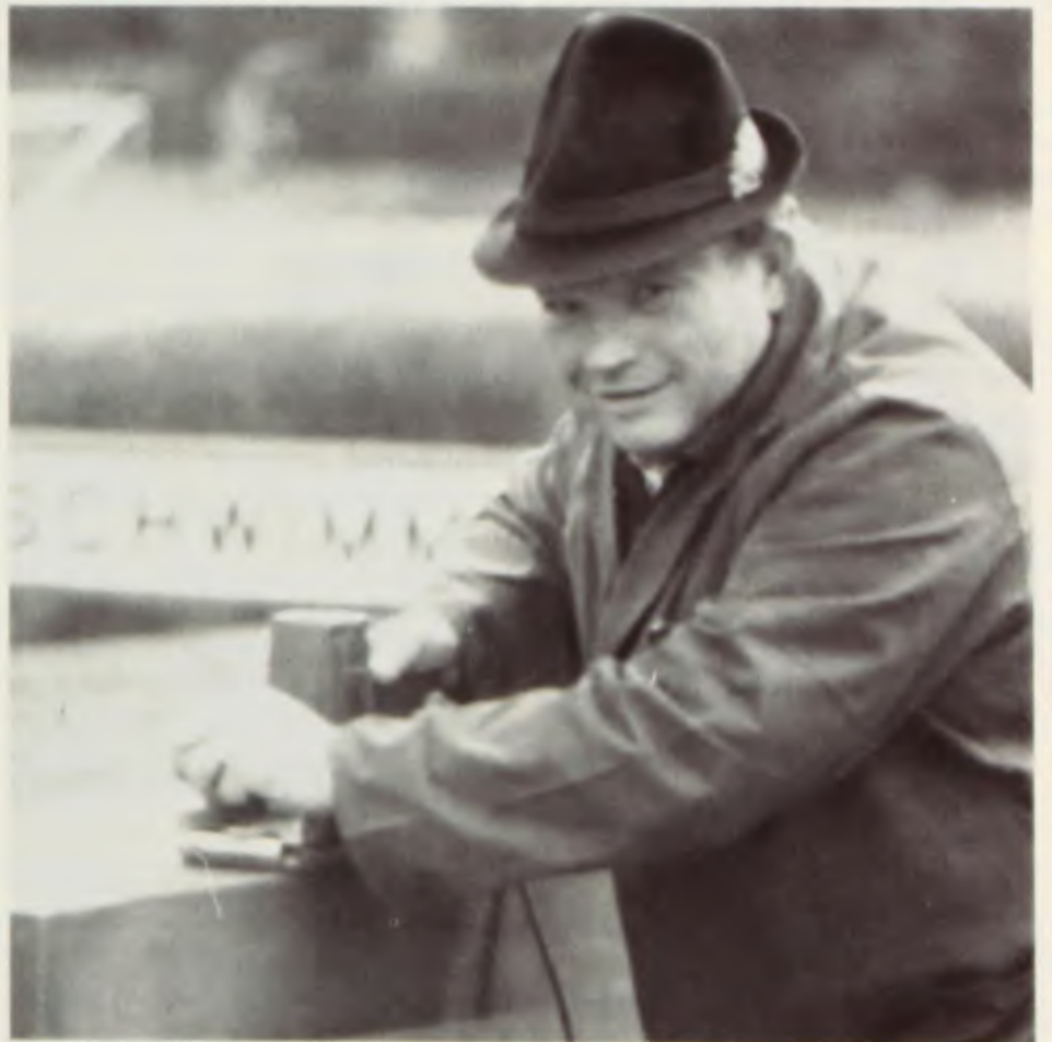
Edi Hahn schleift hier den letzten Winterrost von der Schwimmbadbeleuchtung, die anschließend auch noch frisch gestrichen wurde.
