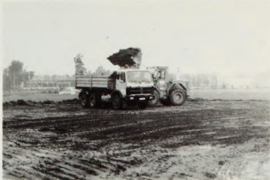
Der Radlader ist im Einsatz. Er verwandelt das ehemalige Hockeyfeld in eine Baustelle.
