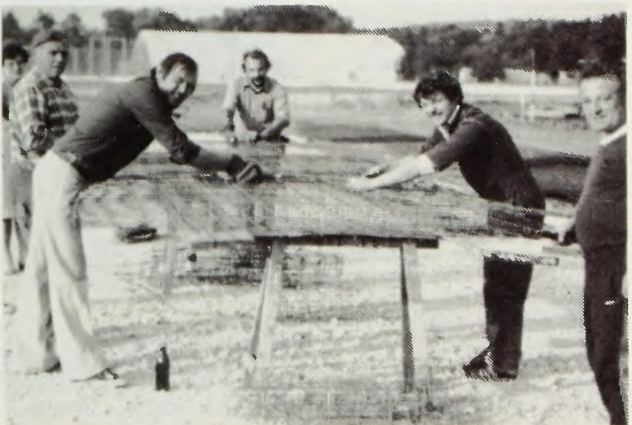
Freiwillige Helfer beim Montieren der Stahlmatten.
