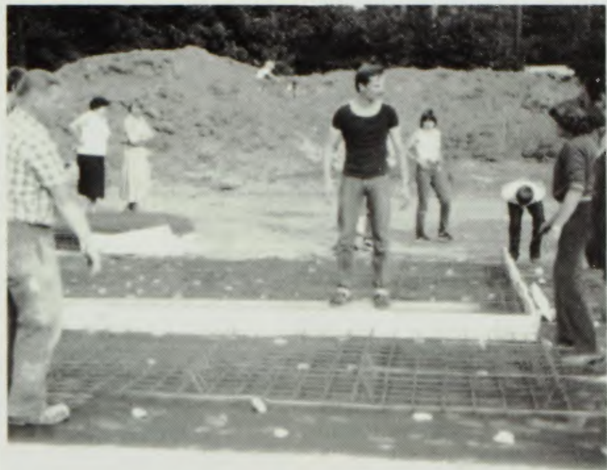
Die Stahlmatten für die Kunstlauf- und Hockeybahn werden verlegt und verlugt.
