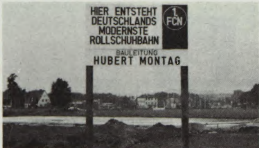
Bau unserer neuen Rollsportanlage.
