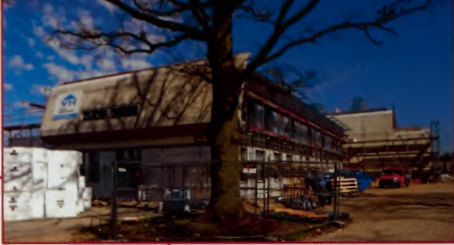
Auf der linken Stirnseite des Neubaus werden die Profis ein- und ausgehen, im Juni 2012 scheint dies noch weit entfernt.
