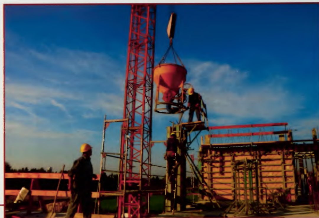
In der Sommersonne im Juli 2011 nimmt das Erdgeschoss Formen an.
