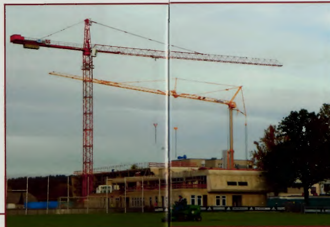
Im November 2011 steht der Rohbau schon, die imposanten Kräne prägen lange das Panorama am Sportpark.
