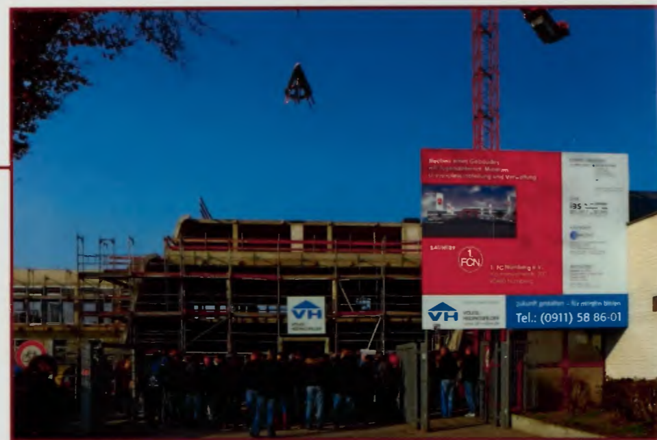
Eine Krone schmückt ab dem 11. November 2011 anlässlich des Richtfests den Rohbau.
