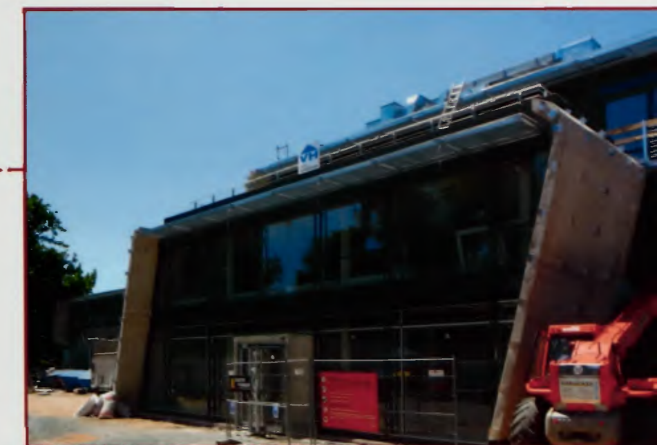
Sprung in den Mai 2012: Die Glassassade am Eingangsbereich ist eingefasst.
