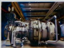
Die beiden Gasturbinen erzeugen über 120.000 PS bei 6.600 U/min.
