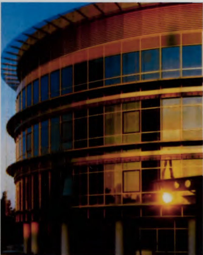
CCN-West in der Außenansicht.
