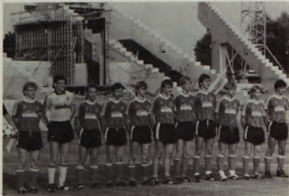
Die Club-Elf vor dem Anpfiff. Im Hintergrund zu erkennen: die „Baustelle Gegen-gerade“, an der während des Finales fleißig gewerkelt wurde.
