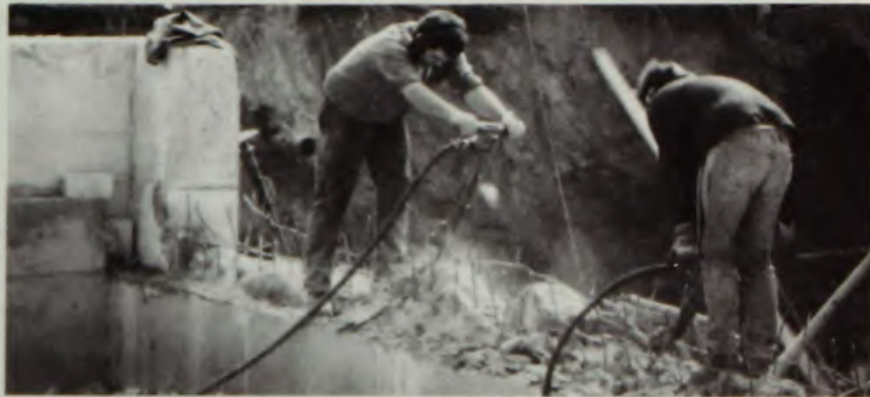
Um die Beckenlänge von 50m einzuhalten, mußte eine Wand abgetragen werden.
