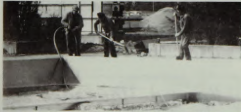
Im Nichtschwimmerbecken sind Überlaufrinne, Seitenwände und Einlaufkanäle bereits montiert.
