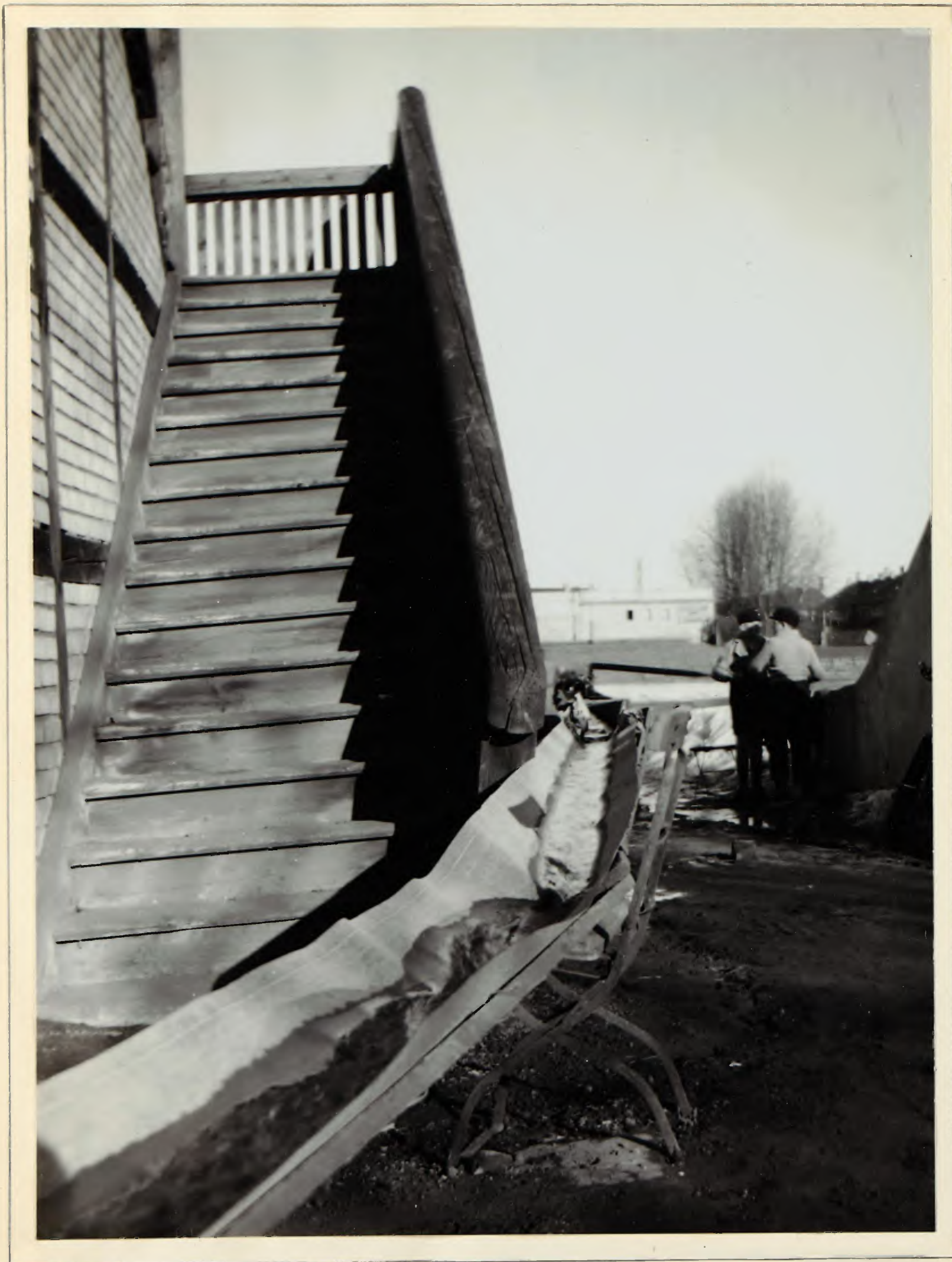
Der Wasserablauf zum Kanal
