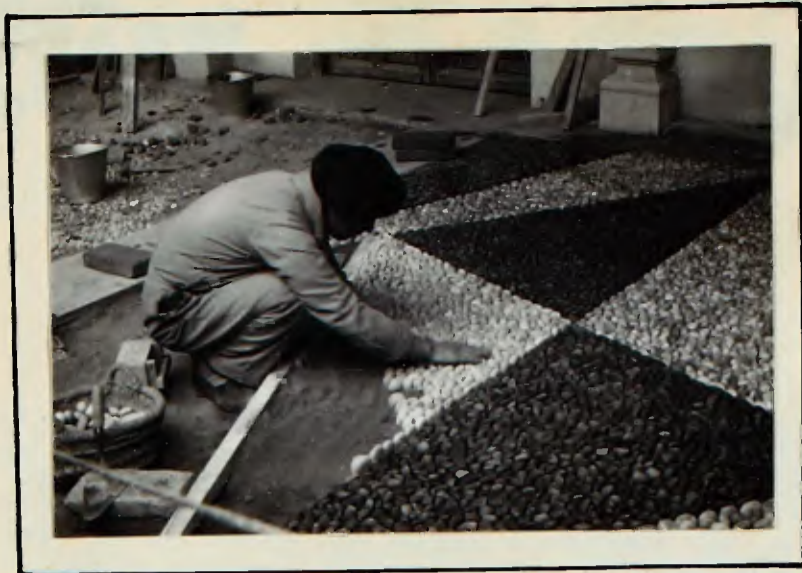
Fußbodenleger in einer Kirchen
